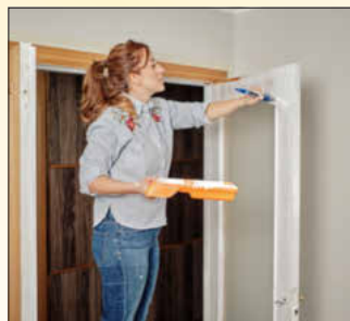
Frischer Look in nur einem Arbeitsgang: Spezielle Lacke verhindern Farbdurchschläge und sorgen für ein strahlendes Weiß des Türblatts bereits nach dem ersten Anstrich.
