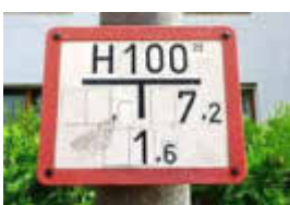
Hinweisschild für einen Unterflurhydranten
